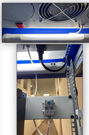
Slika 53. Pogled u bateriju, ventilator svjetiljku i termostat
