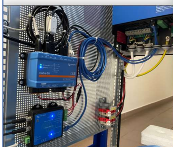
Slika 54. Pogled u Cerbo GX VE.Bus BMS V2 i upravljačko nadzornu zonu
